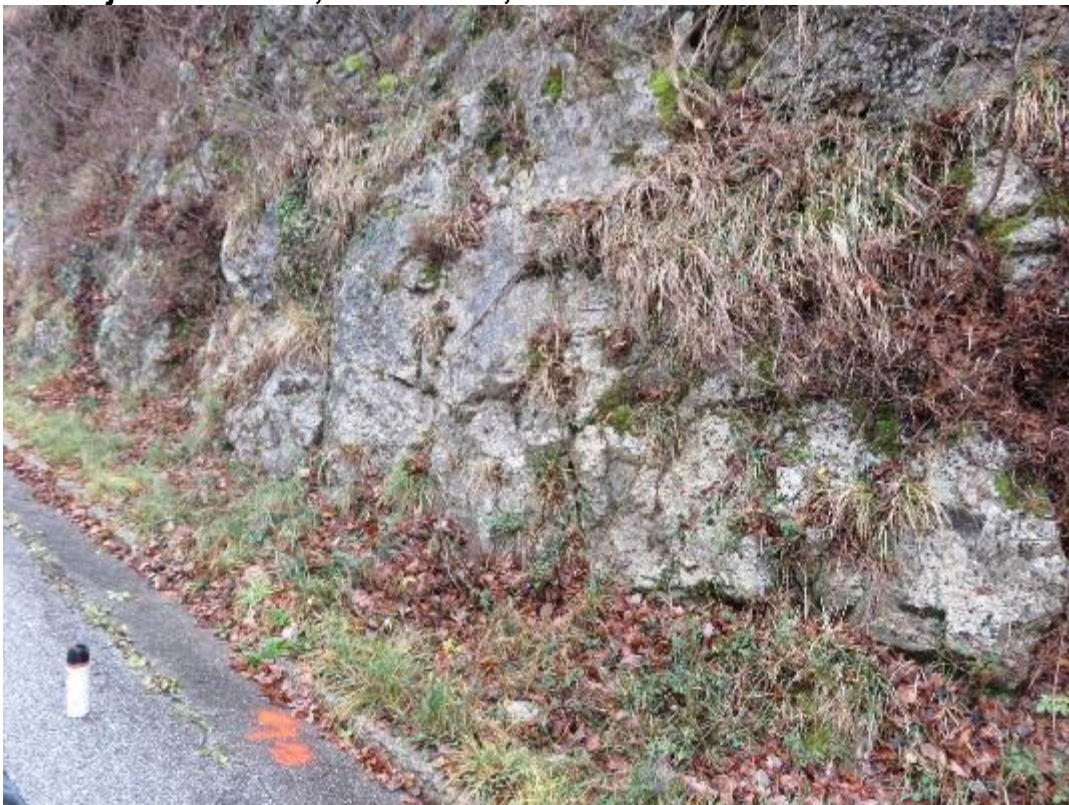
Lokacija 13 od km 8,077 do km 8,115
