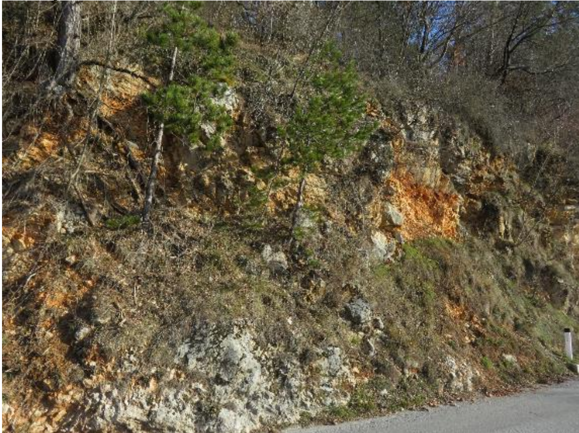
Lokacija 5 od km 1,180 do km 1,220
