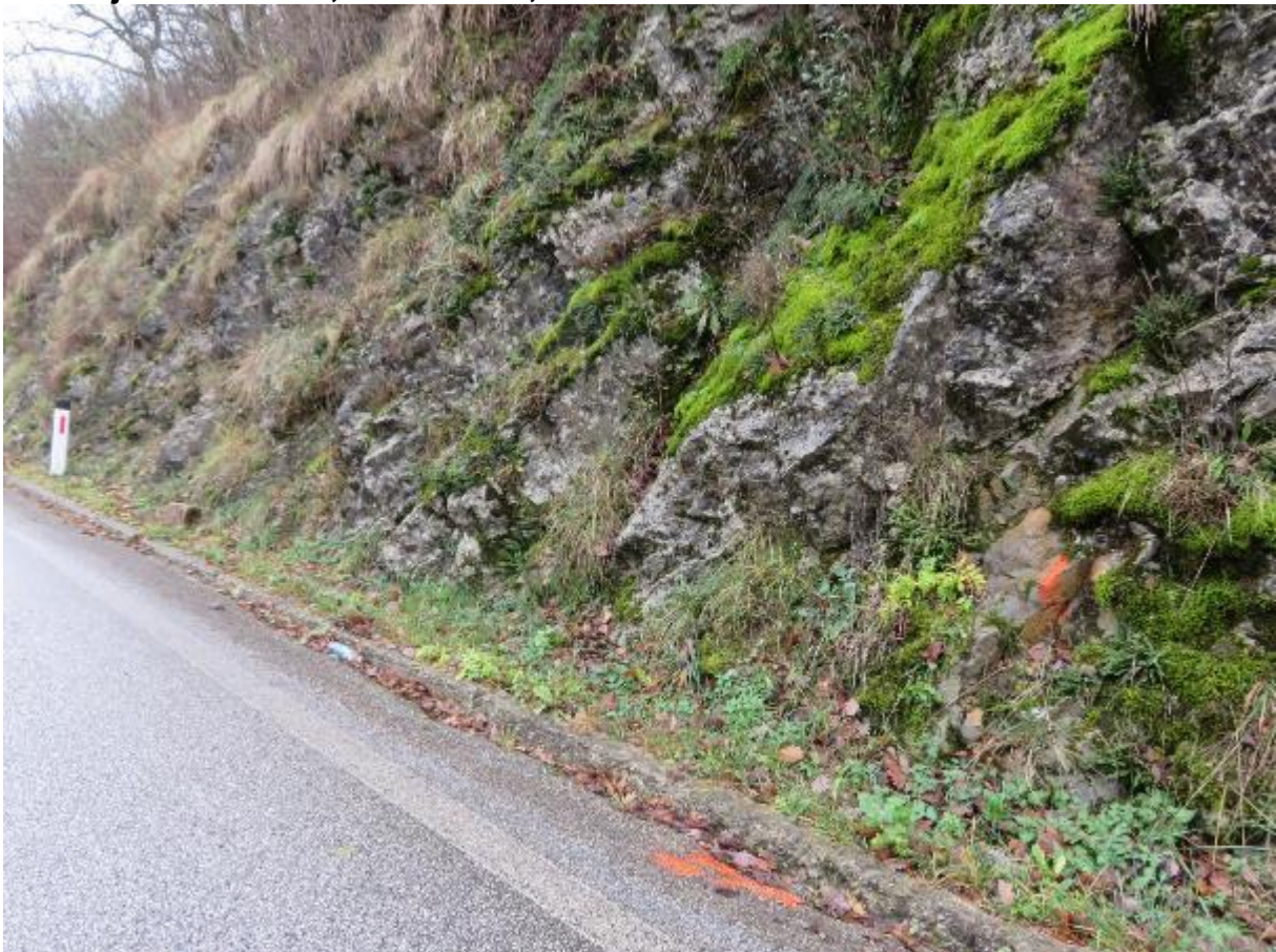
Lokacija 11 od km 7,981 do km 8,004
