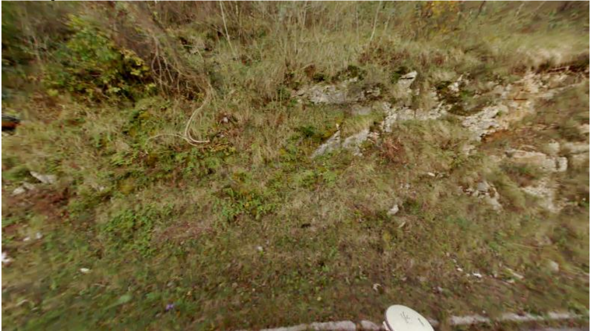
Lokacija 10 od km 7,926 do km 7,958
