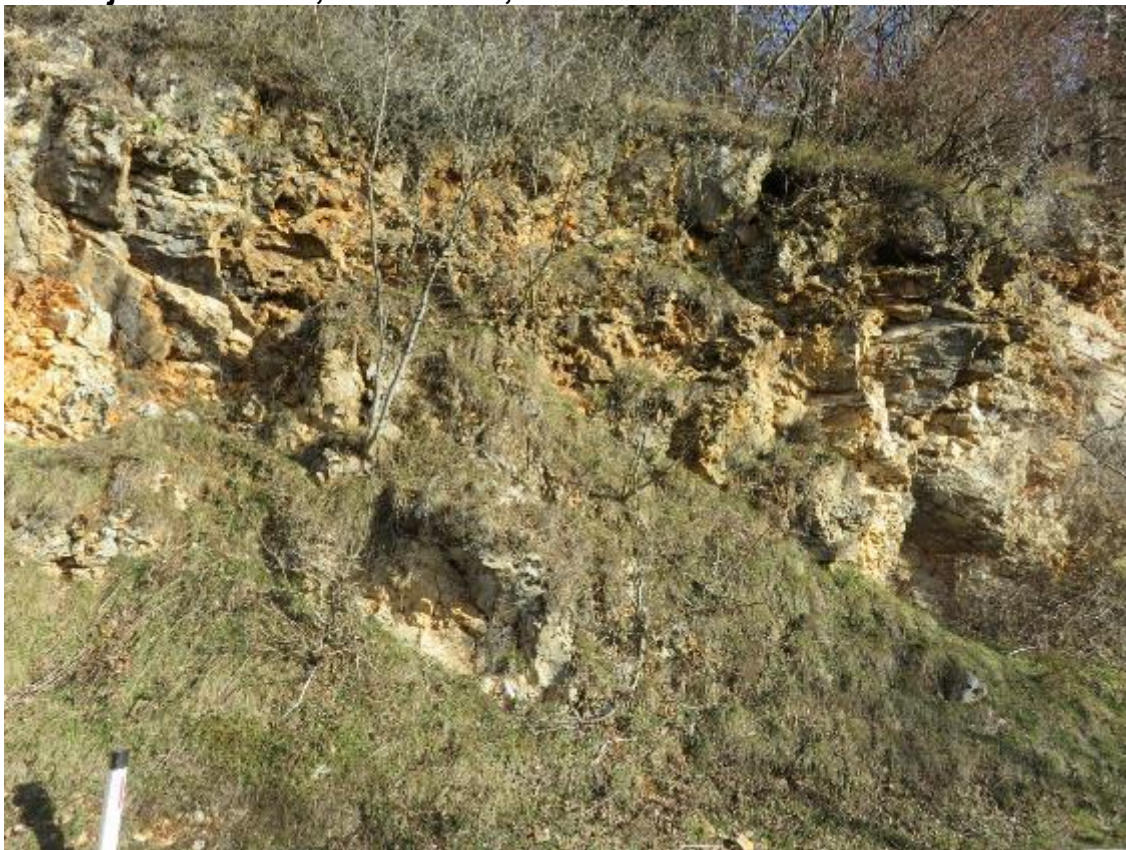
Lokacija 6 od km 1,220 do km 1,240
