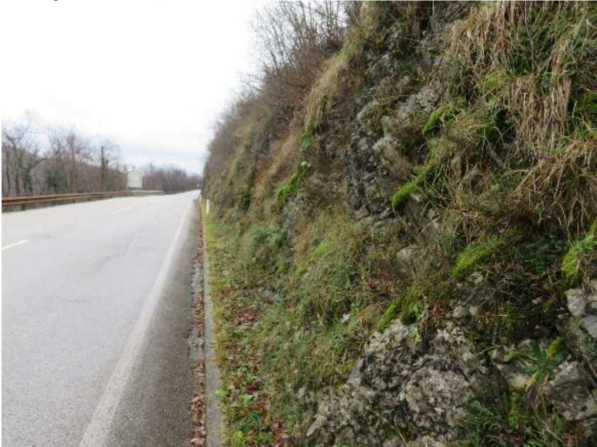
Lokacija 12 od km 8,004 do km 8,077
